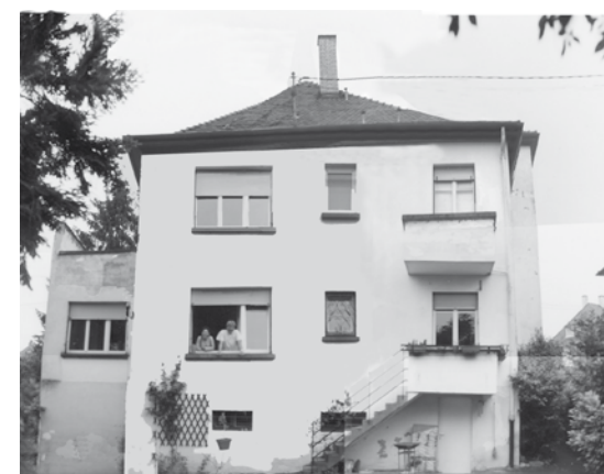
Façade sud avant travaux
