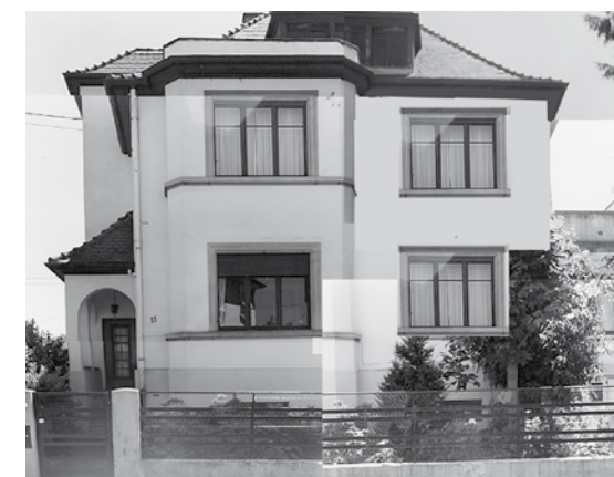
Façade nord avant travaux
